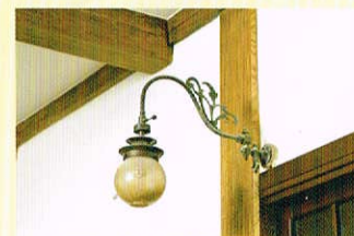
食堂に設けられた建築当初からと見られるガス燈
